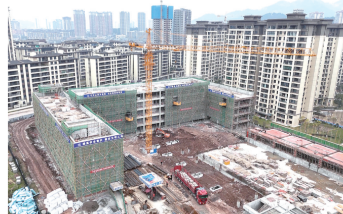
丰泰小学施工现场。
