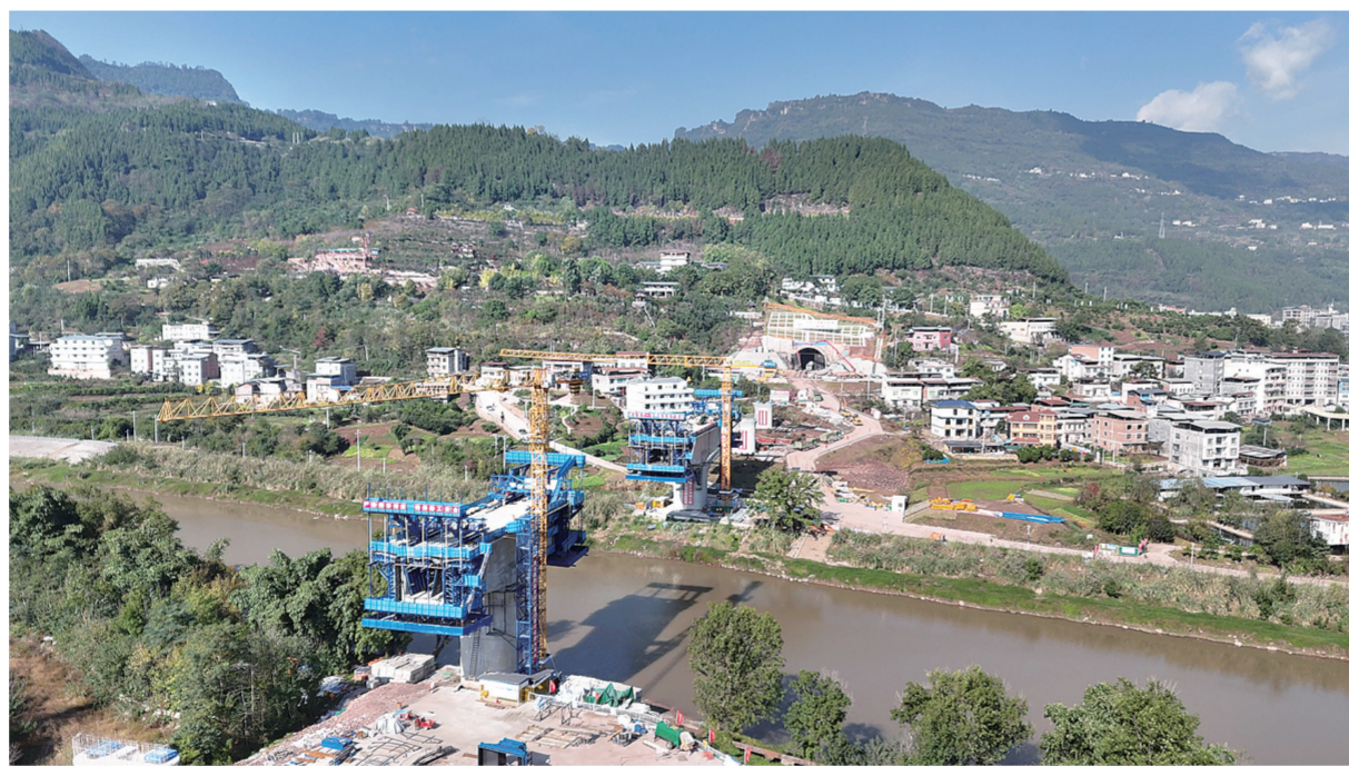
西渝高铁开州段建设现场。
