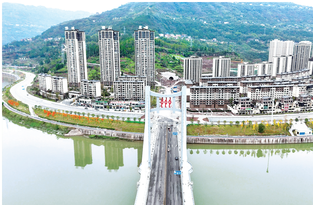
开州大桥北环路连接道(二期)工程正在加紧施工。
